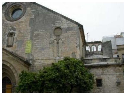
fig 1. Iglesia de San Dionisio de Jerez de la Frontera (Cádiz). Fachada Sur.
