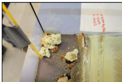
fig 6. Fotografía de las eflorescencias en el simulador.
