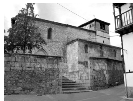
fig 1. Iglesia de Santo Tomás de Covarrubias. Fachada Sur y muro exterior.
