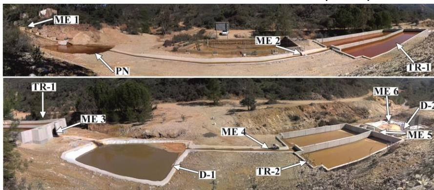
fig 1. Imagen de la planta de tratamiento DAS de Mina Esperanza. ME X (puntos de toma de muestras), PN (Pre-tratamiento), TR-X (Tanques reactivos), D-X (Decantadores).
