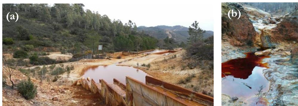
**Fig. 1.** Fotografía de: (a) Mina Esperanza (sistema de tratamiento pasivo DAS: cascada de aireación, balsa de decantación y tanque de tratamiento) y (b) AMD procedente de Peña del Hierro (Río Tinto).
