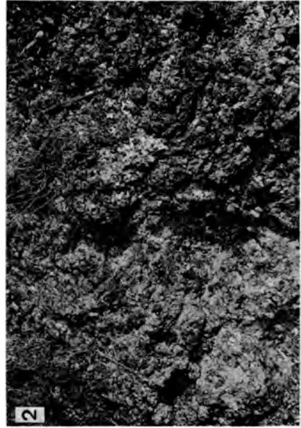
Foto 2.— Yacimiento de las Gacías, galería inferior. Niveles arcillosos, junto a la entrada; sobre ellos aparece una costra de celestina removilizada (zona más contrastada).
