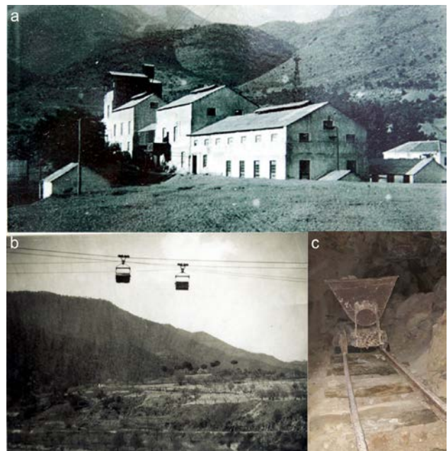
Fig. 2. a) Instalaciones de tratamiento del mineral de S.M.M. Peñarroya en Tablones (Órgiva) a mitad del s. XX. b) Vista del antiguo cable aéreo para el transporte del mineral. c) Vagoneta y sistema de railes empleado, que aún se conservan en algún sector de la mina. Fotografías a) y b), cedidas por el Ayuntamiento de Órgiva (Granada).
