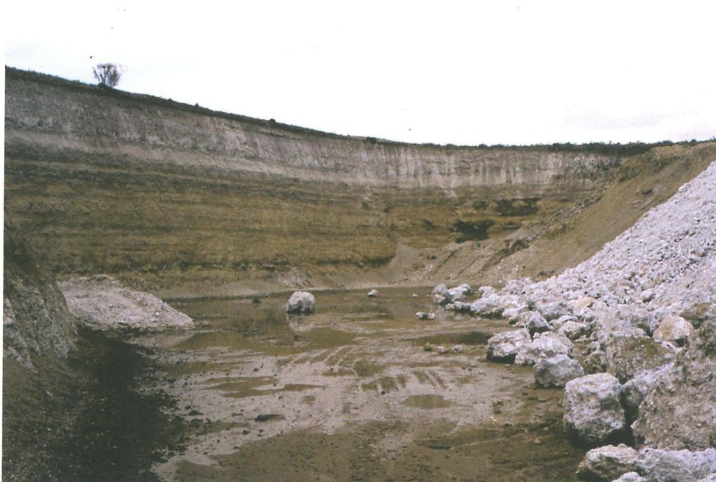
FIGURA 11. *Explotación por transferencia de sepiolita en Cabañas de la Sagra, Cuenca de Madrid.*
