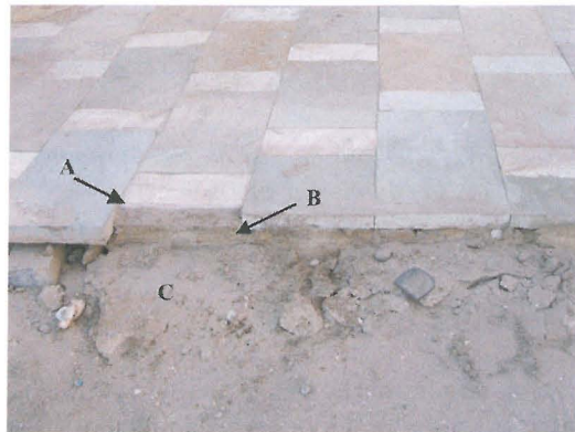
FIGURA 13. Representación esquemática del perfil de la tipología general de las distintas capas de un pavimento para su adecuada colocación. B) Ejemplo de este esquema en la colocación de un pavimento.
