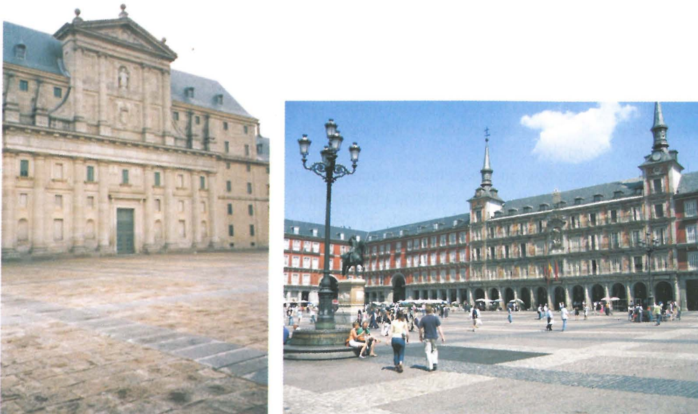
A B FIGURA 2. Ejemplos de uso de piedra en restauración en pavimentos históricos. A) Patio de los Reyes del Real Monasterio de San Lorenzo de El Escorial. B) Plaza Mayor de Madrid.
