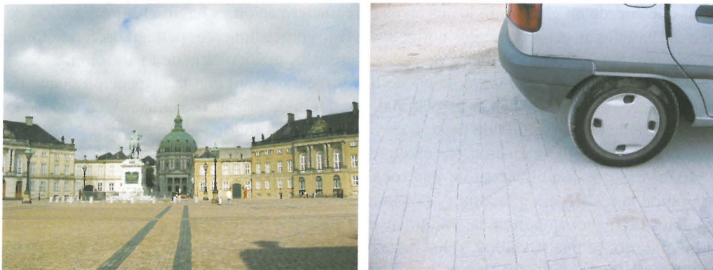
FIGURA 9. Ejemplo de utilización de piedra natural con distintos requerimientos de carga de rotura. A) Pavimento de una plaza pública de tráfico fundamentalmente peatonal y paso ocasional de vehículos ligeros. B) Pavimento en una zona de tráfico de vehículos.
