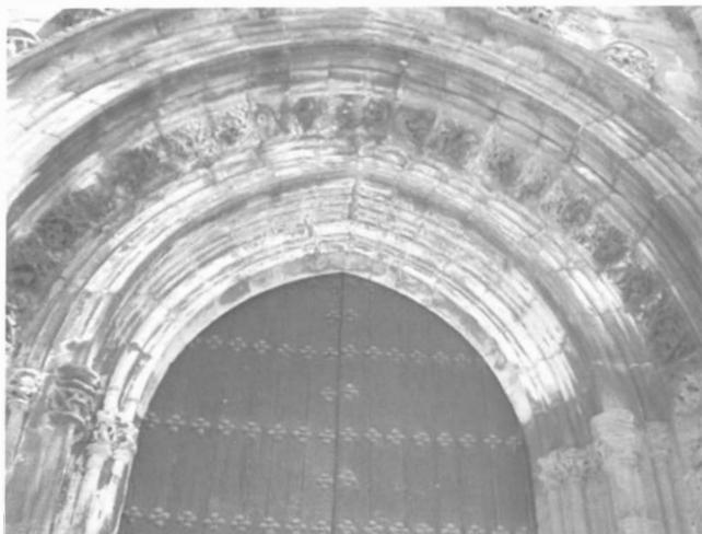
Figura 1: Arquivolta sur con eflorescencias de epsomita.
