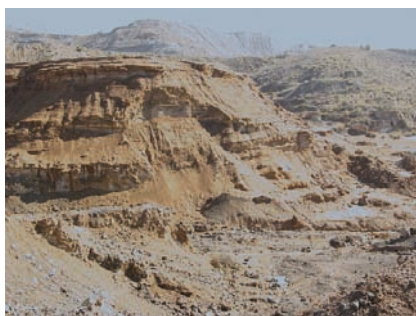
Fig. 1. Antigua balsa de estériles parcialmente erosionada por la rambla de El Avenque.
