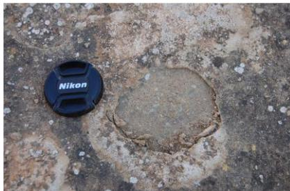
**Fig 10.** Descamaciones circulares de arenisca por presencia de líquenes del género *Displochistes*.
