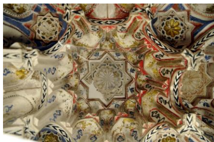
fig 1. Bóvedas de mocárabes policromadas.
