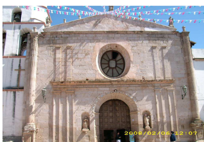
fig 2. Estado de la fachada de la iglesia de San Juan Bautista antes de iniciar las obras de restauración.
