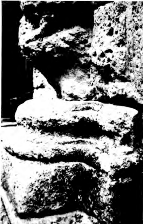
FOTO 1.- Detalle pérdida material.
